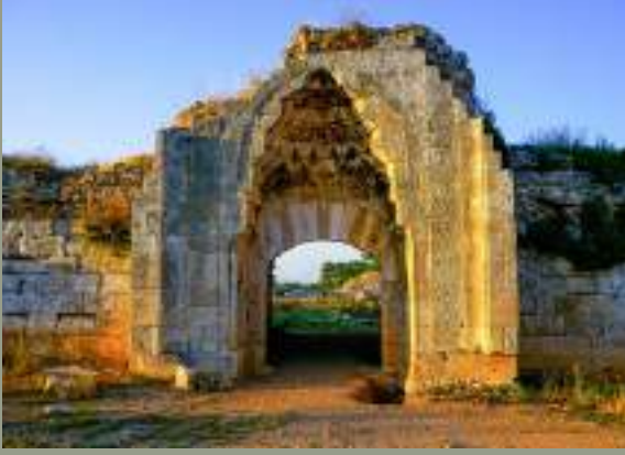
Evdır Hanın güney cephesi üzerinde yer alan taçkapısı.
